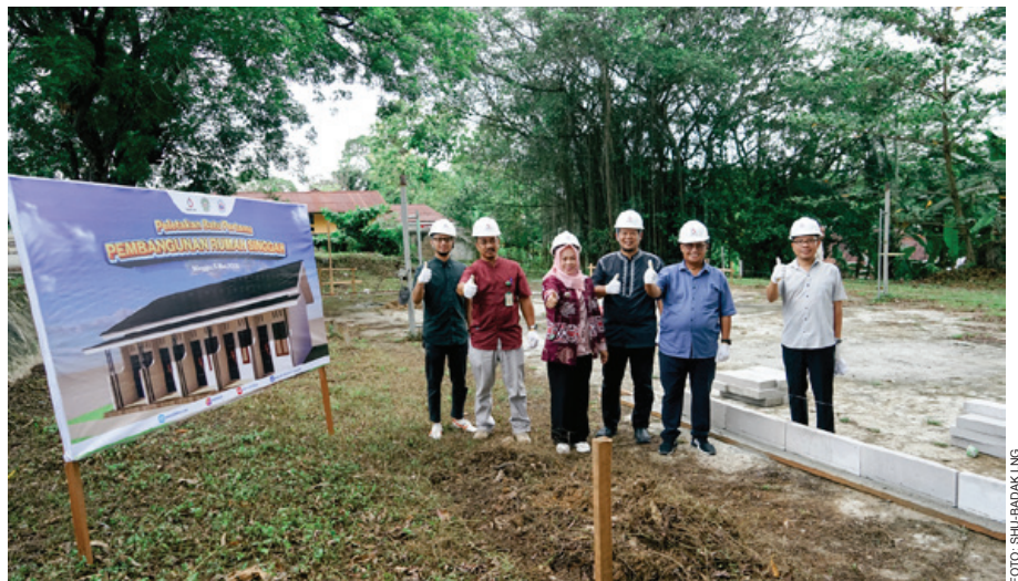
FOTO: SHU-BADAK LNG
