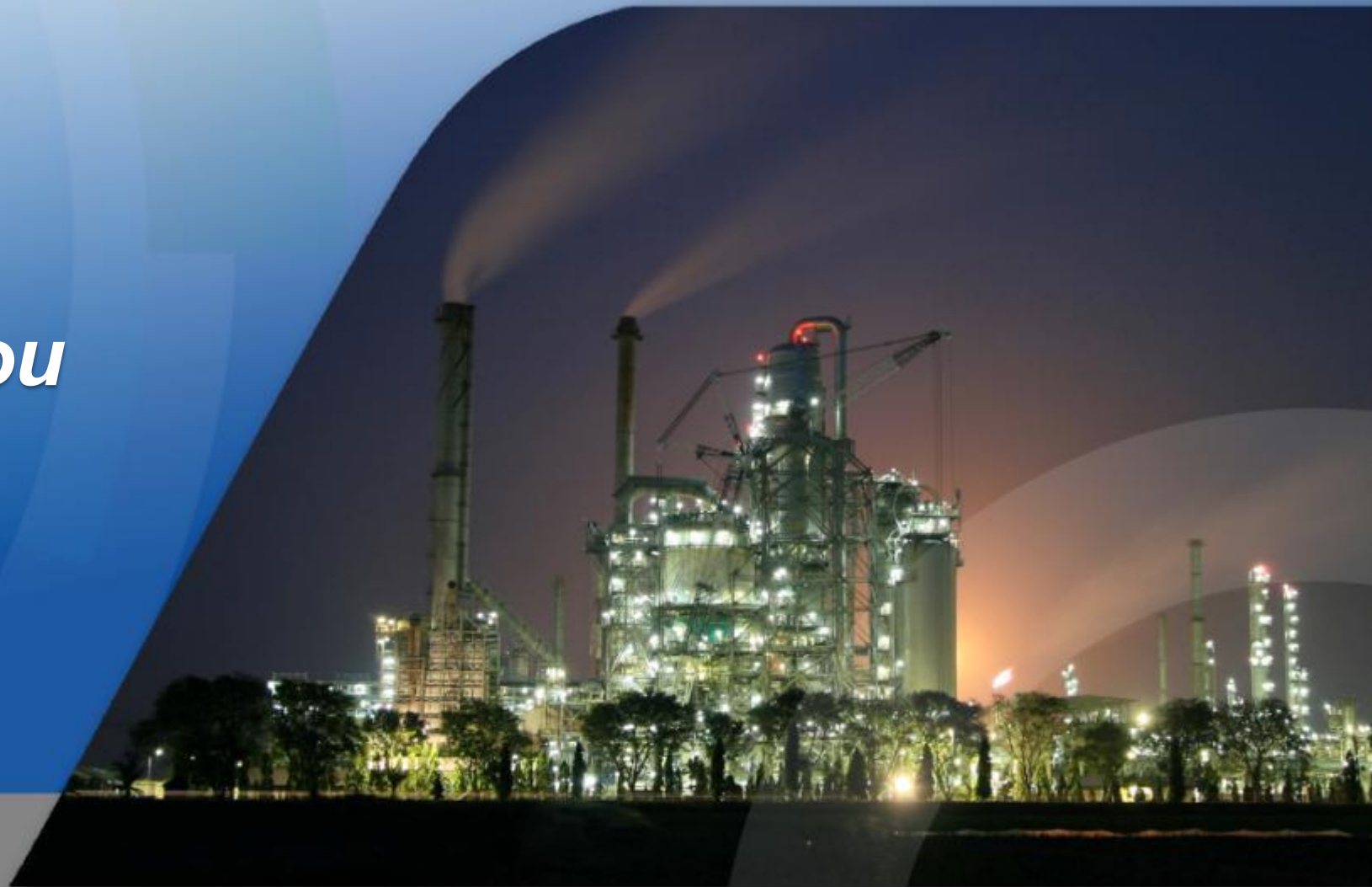
Refinery Unit VI Balongan
